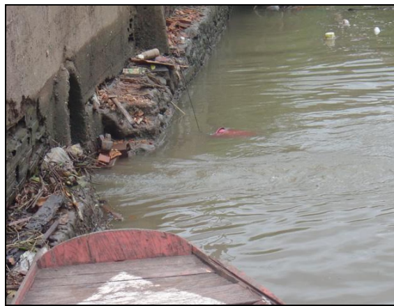
Fotografia 37 – Tubulação de drenagem a jusante da Rodovia Arthur Bernardes. Fonte: Direta (2006)
