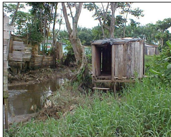
Fotografia 33 – Banheiro lançando esgoto sanitário às margens do igarapé Mata Fome. Fonte: Direta (2006)
