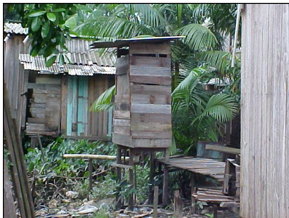
Fotografia 32 – Banheiro lançando esgoto sanitário no solo. Fonte: Direta (2006)
