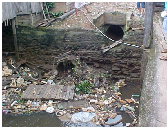
Fotografia 36 – Tubulação de drenagem a montante da Rodovia Arthur Bernardes. Fonte: Direta (2006)
