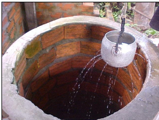
Fotografia 26 – Poço tipo Amazonas, Bacia do Mata Fome. Fonte: Direta (2006)
