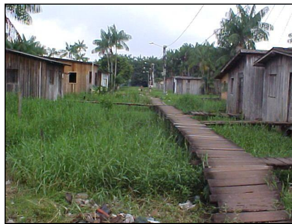
Fotografia 35 – Construção de estivas, Bacia do Mata Fome Fonte: direta (2006)
