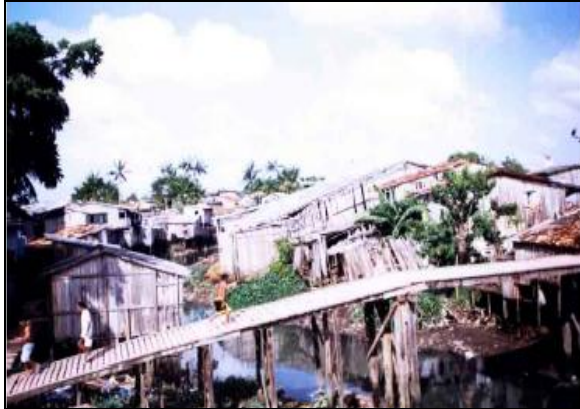
Fotografia 3 – Igarapé Tucunduba, antes da intervenção urbanística. Fonte: Lisboa e Mello (2003)
