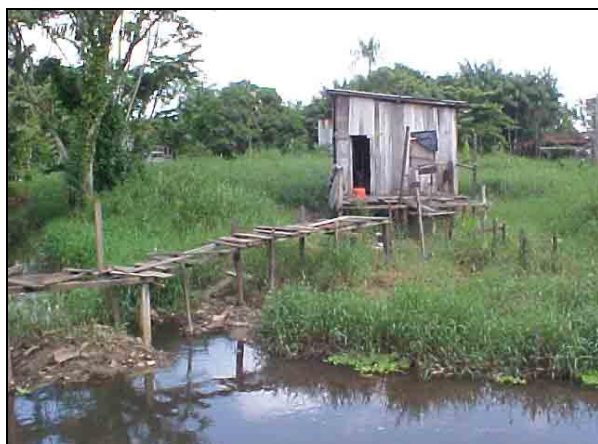
Fotografia 39 – Construção de casas nas margens do igarapé. Fonte: Direta (2006)
