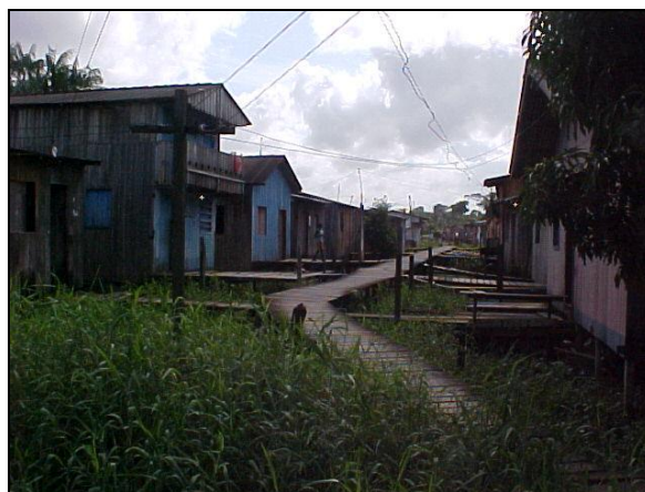
Fotografia 40 – Construção de casas nas margens do igarapé. Fonte: Direta (2006)
