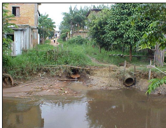
Fotografia 38 – Tubulações de drenagem com lançamento no igarapé Mata Fome. Fonte: Direta (2006)
