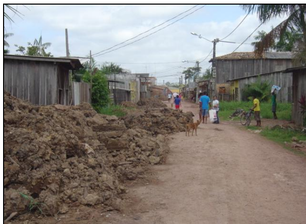
Fotografia 34 – Rua aterrada, Bacia do Mata Fome Fonte: direta (2006)
